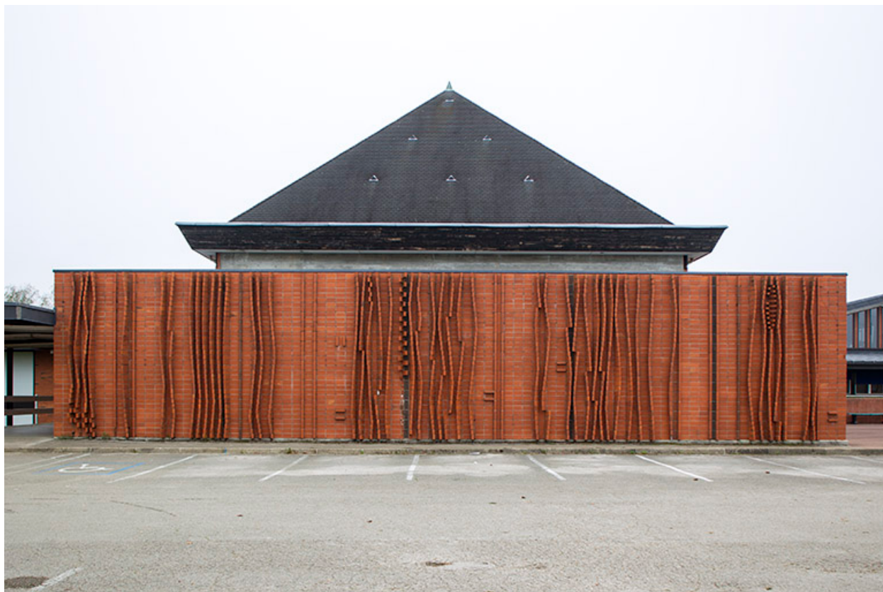
Vue de face du long mur sud.
