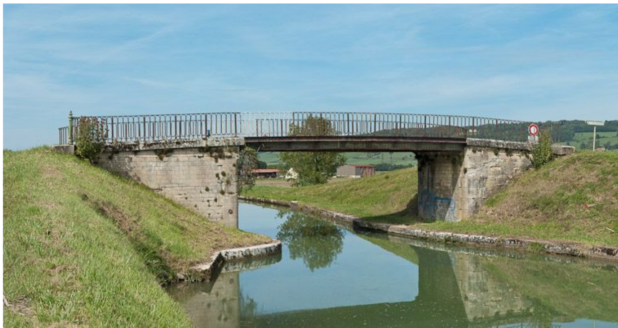
Vue du pont.
