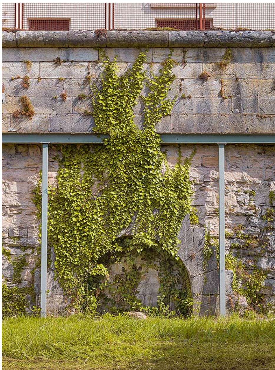
Le mur d'escarpe étayé (détail).
