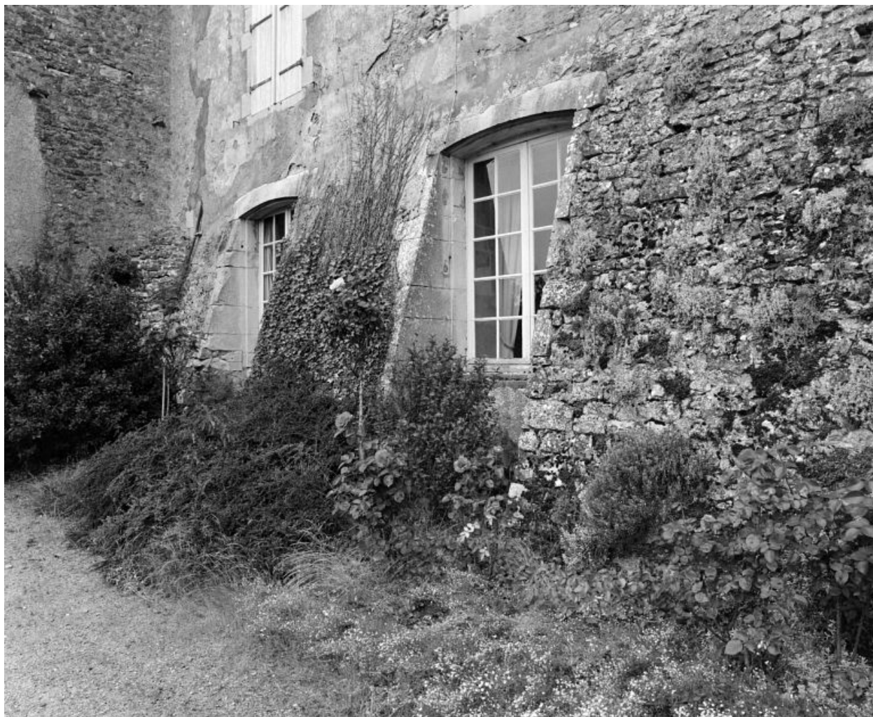
Bâtiment sud-ouest. Elévation antérieure, détail.
