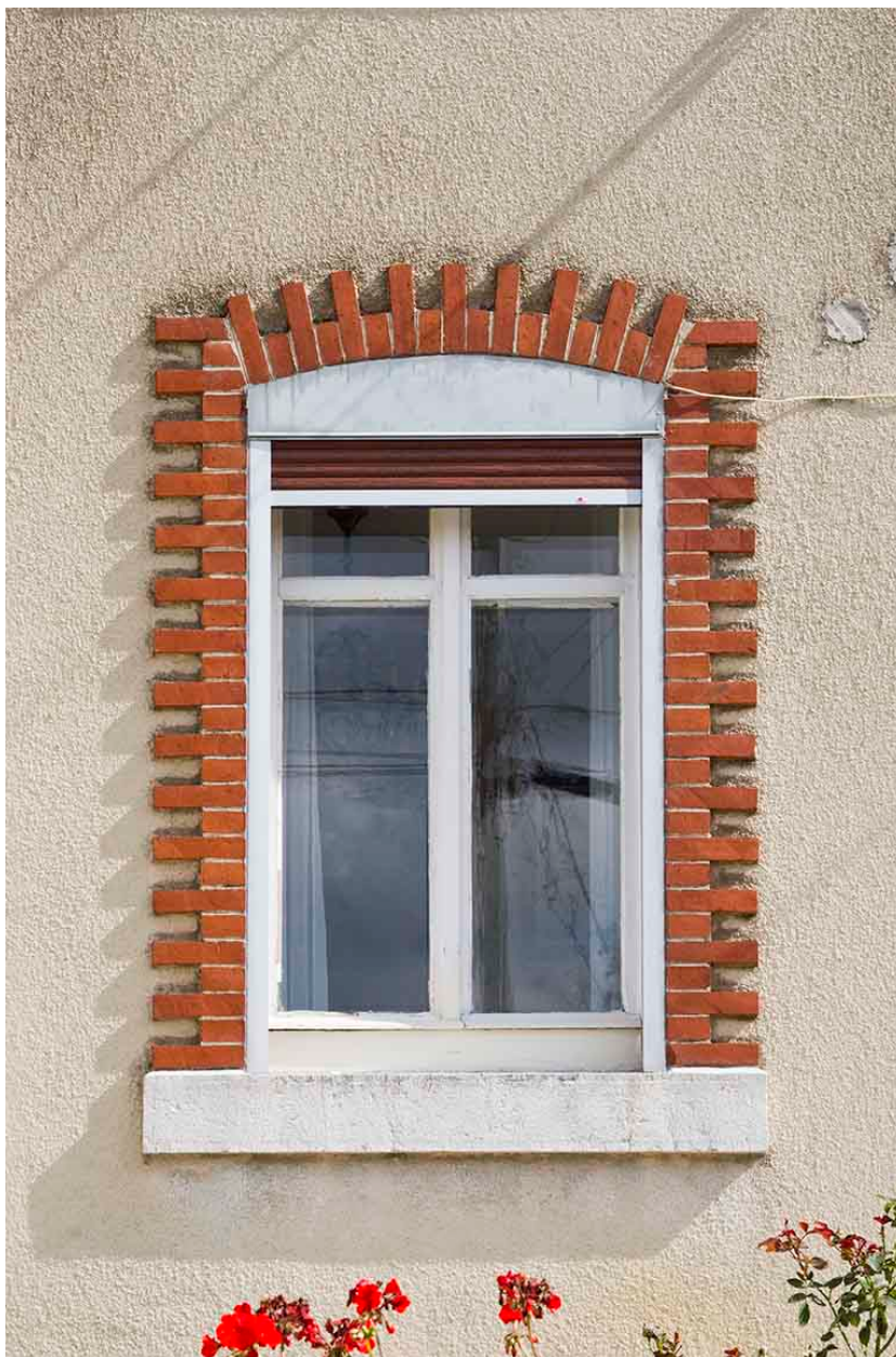
Maison, façade antérieure : fenêtre à encadrement en briques et arc segmentaire.
