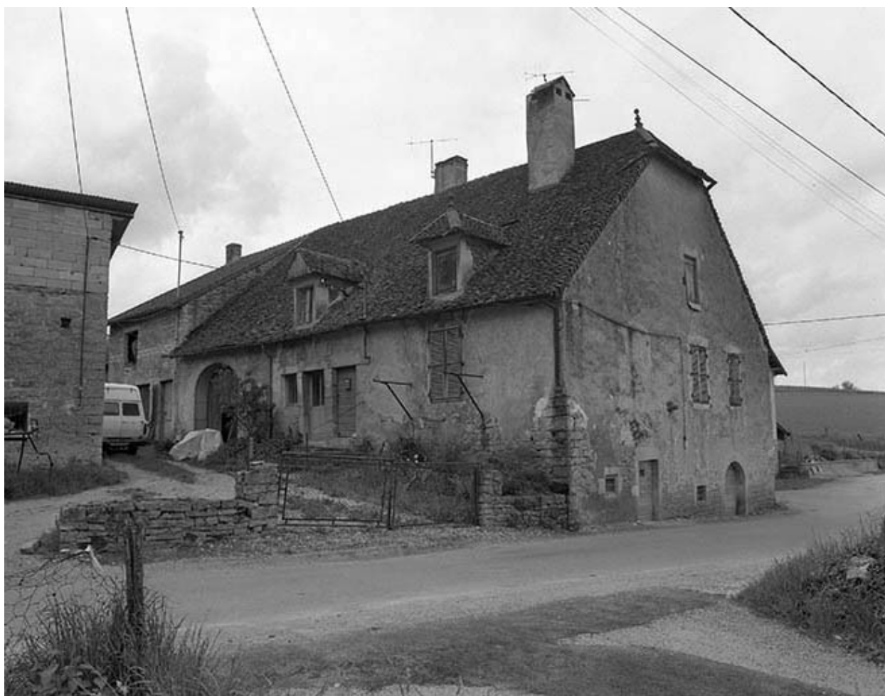
Ferme située rue des Louvarets : vue d'ensemble.
