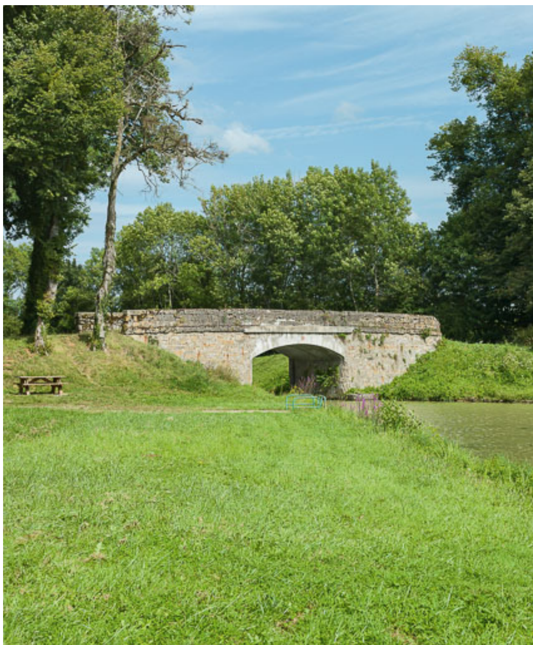
Vue d'ensemble du pont.
