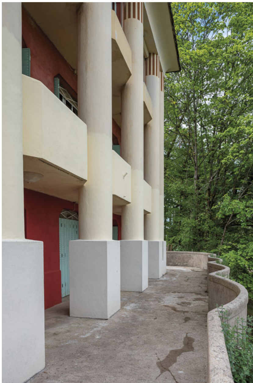
Terrasse de la façade nord.
