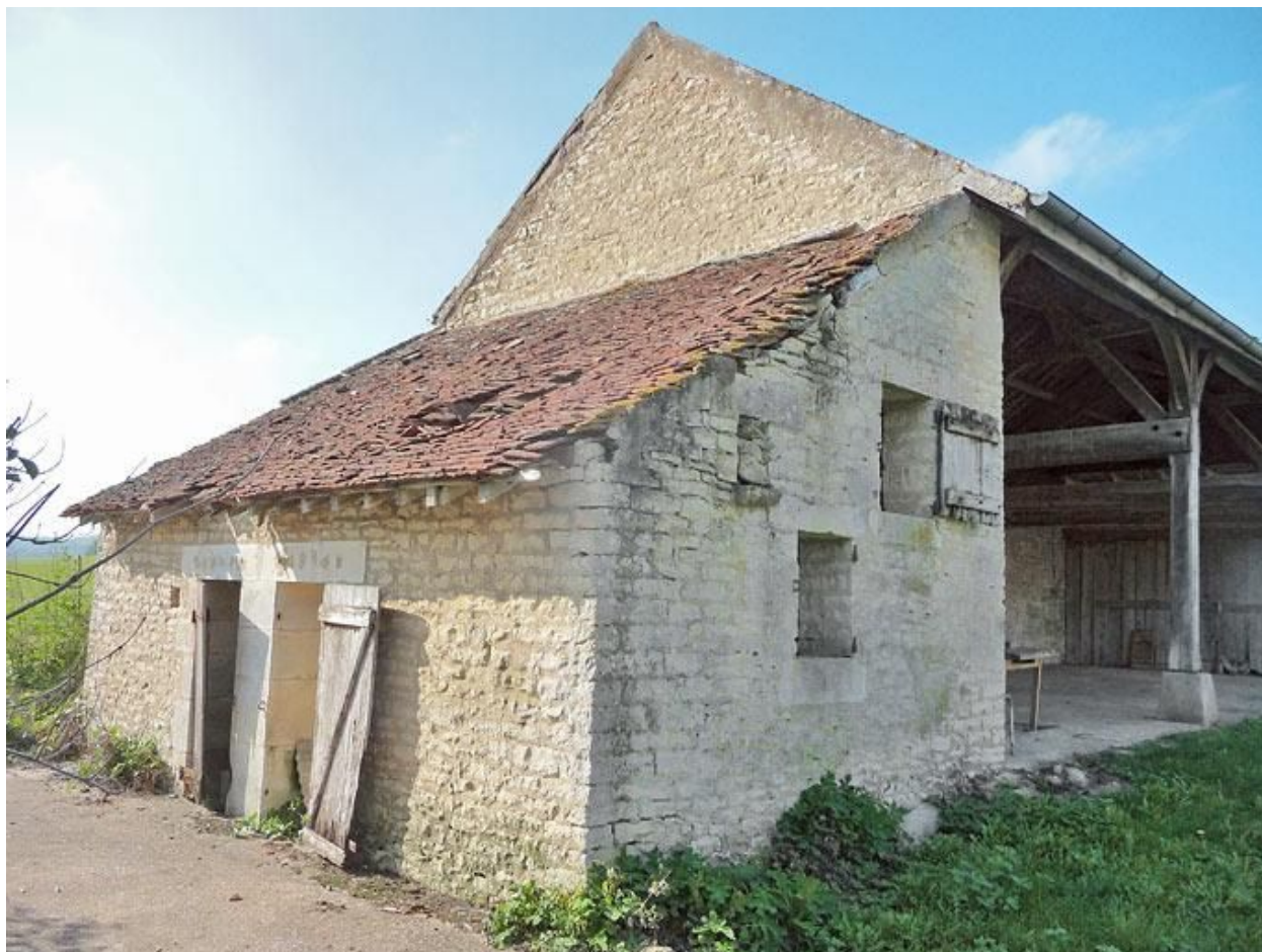
Petite dépendance prolongeant le hangar.
