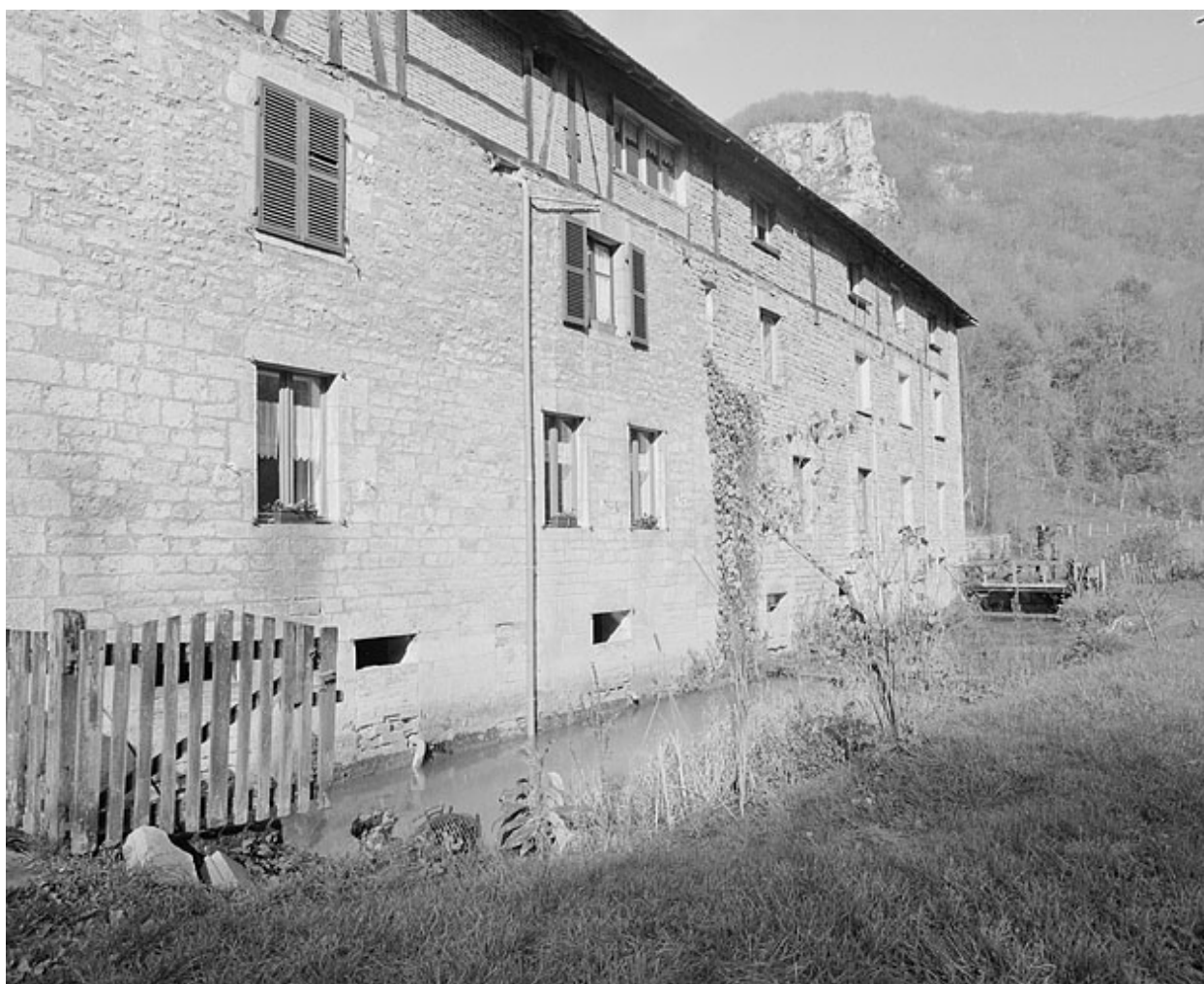
Façade sur le canal depuis le sud.
