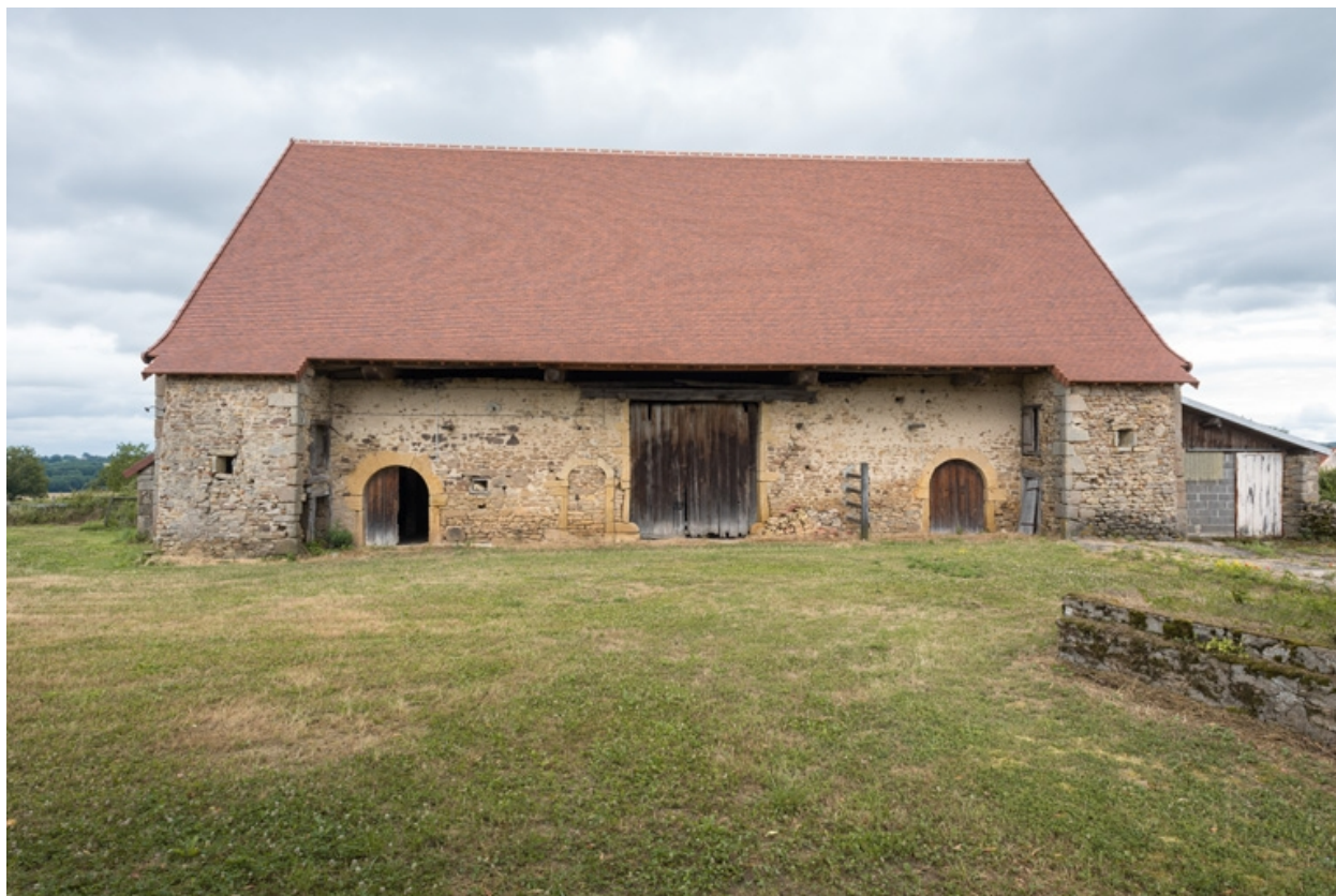
Vue frontale de la grange
