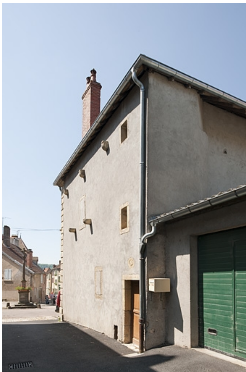
Vue générale de la façade latérale droite.
