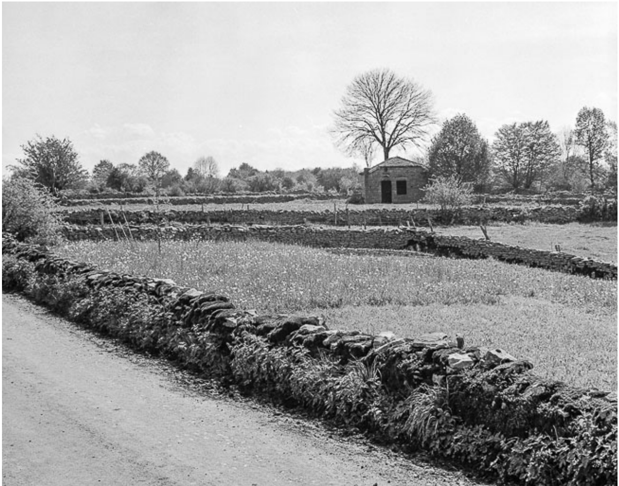
Mur en pierre sèche dit murger.
