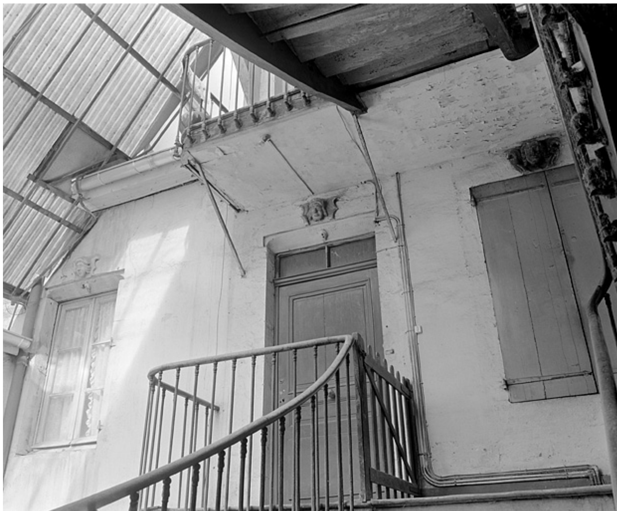
2e étage, élévation sur l'escalier.
