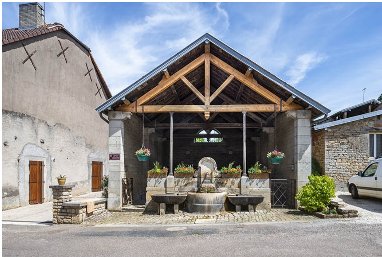
Façade du lavoir.
