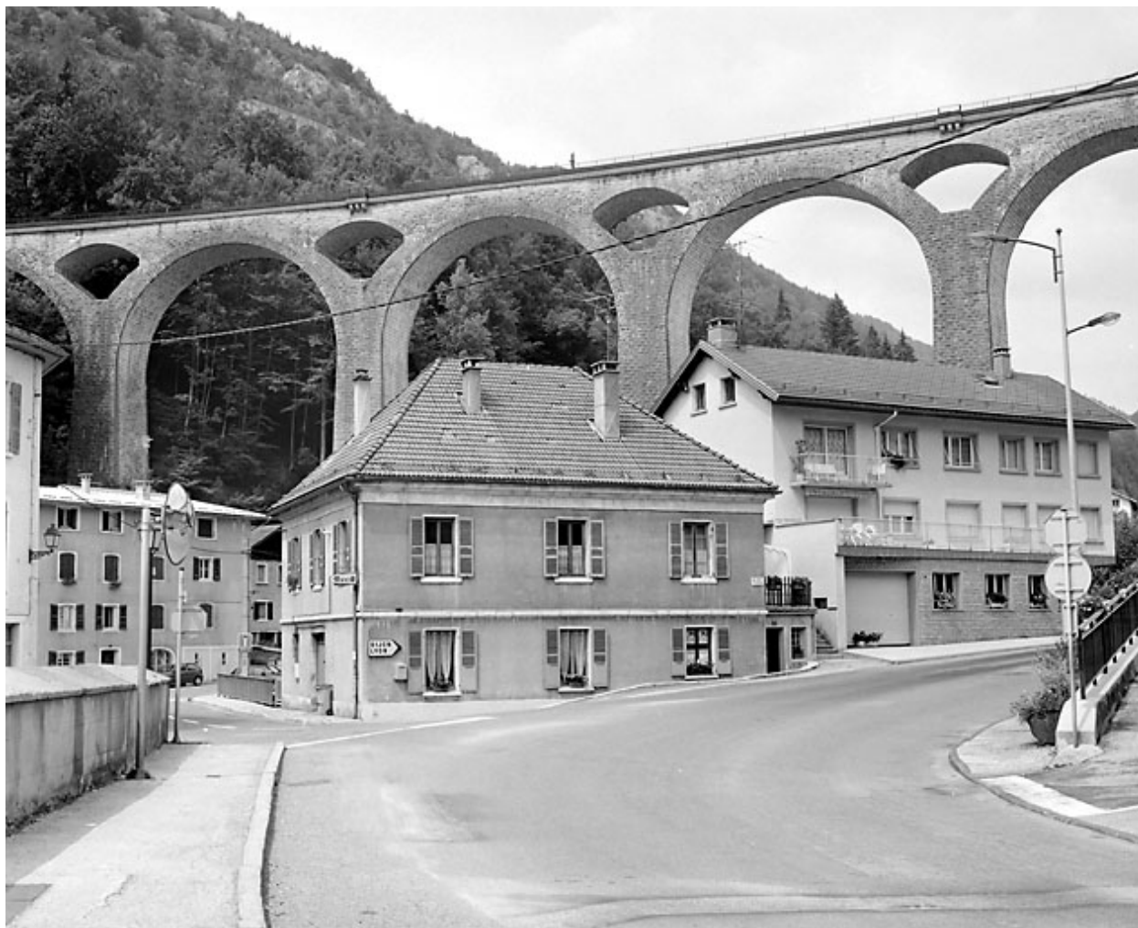
Vue d'ensemble rapprochée, depuis le sud.
