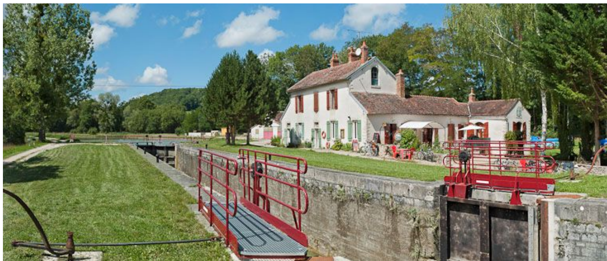
Vue d'ensemble du site d'écluse.
