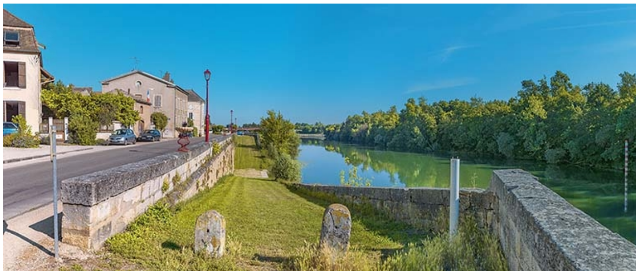
Quais de Verdun : la double rampe.
