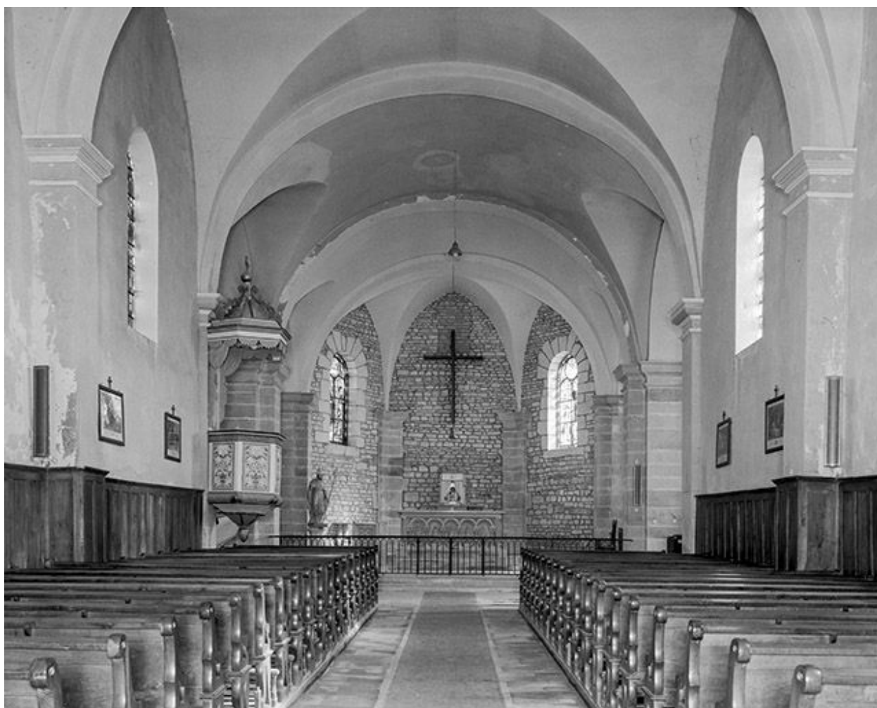
Vue de la nef et du chœur.
