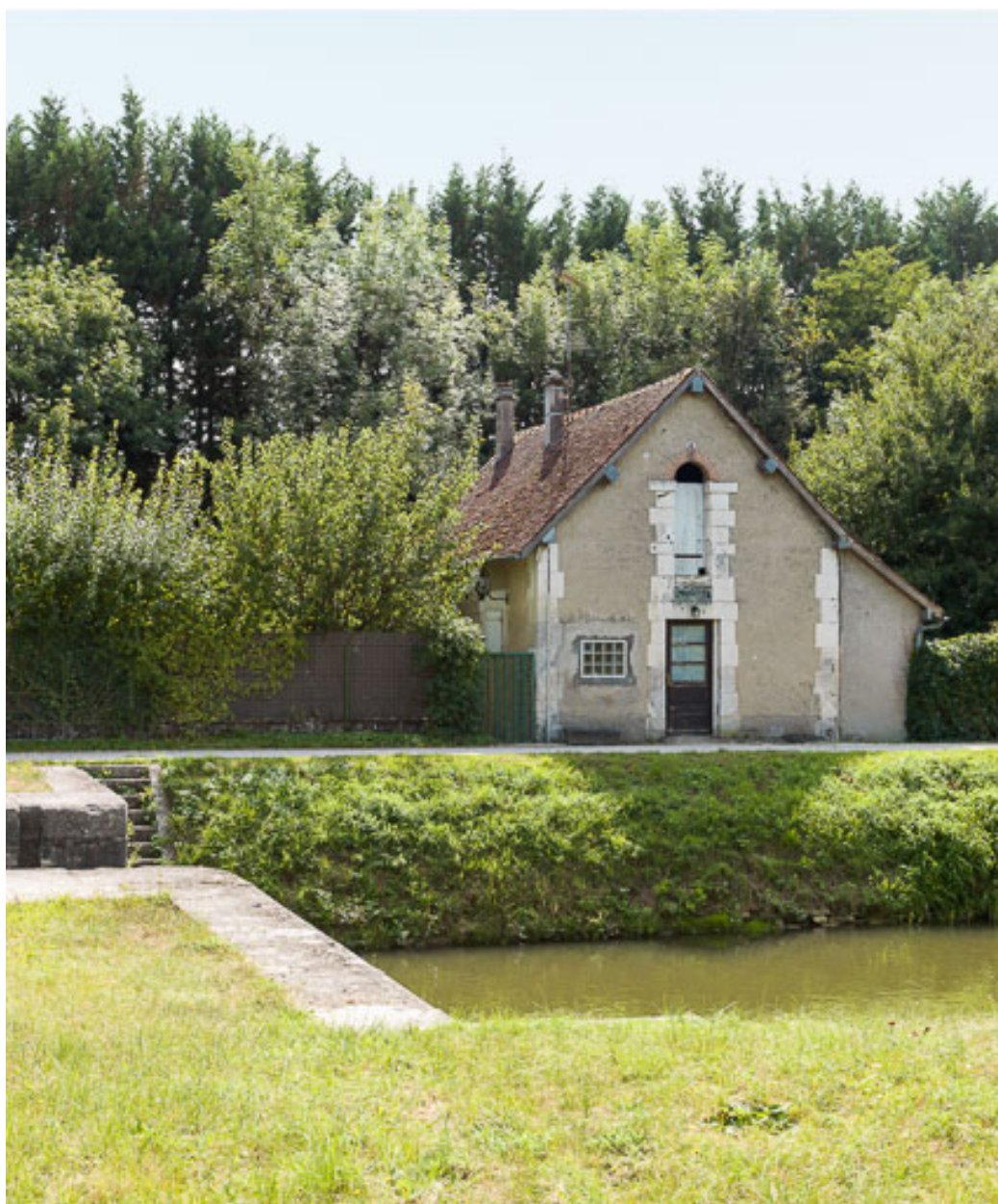
Vue de la maison éclusière.
