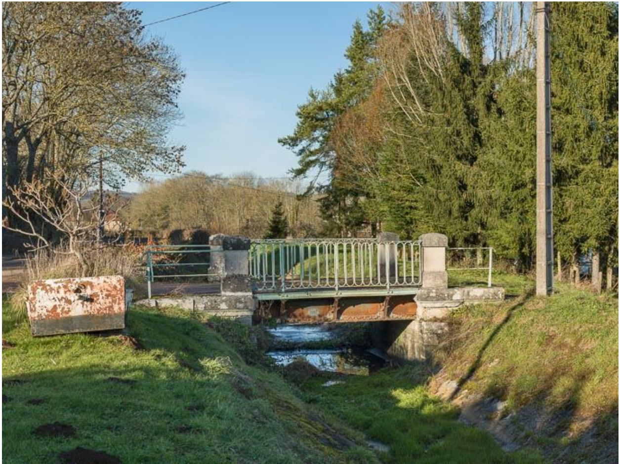
Vue d'ensemble du pont.
