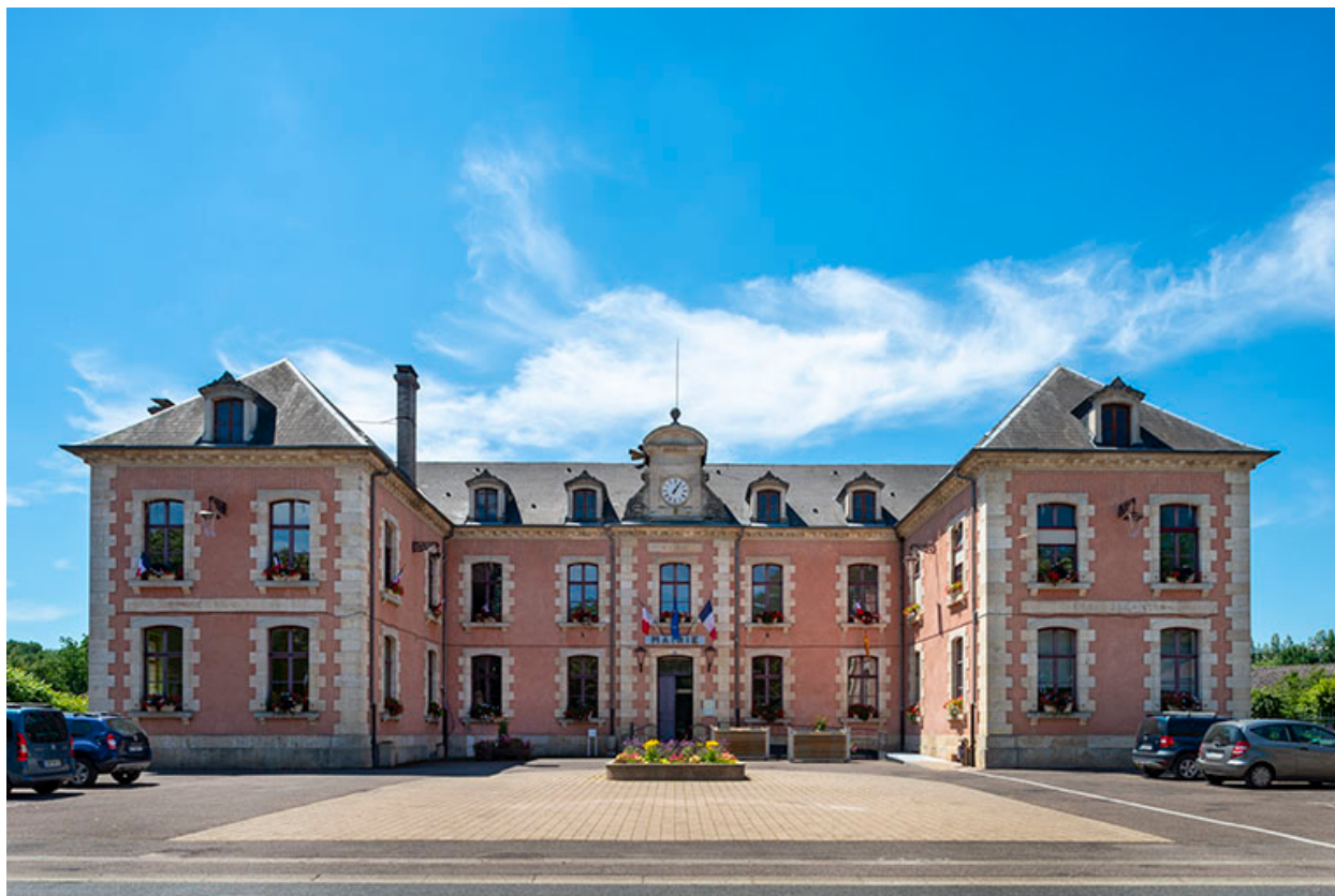
Façade nord-est, vue d'ensemble de face.
