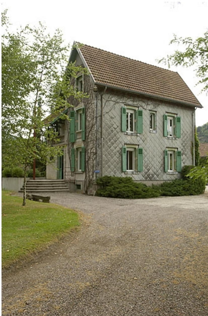
Ancien logement patronal. Vue depuis l'entrée.
