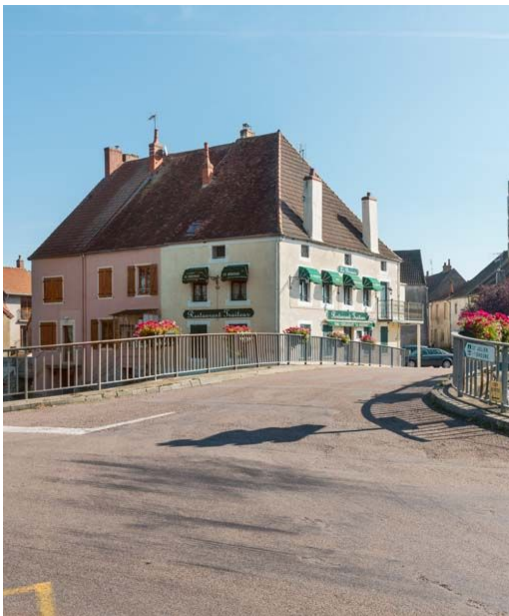
Vue d'ensemble du pont sur le canal et du café.
