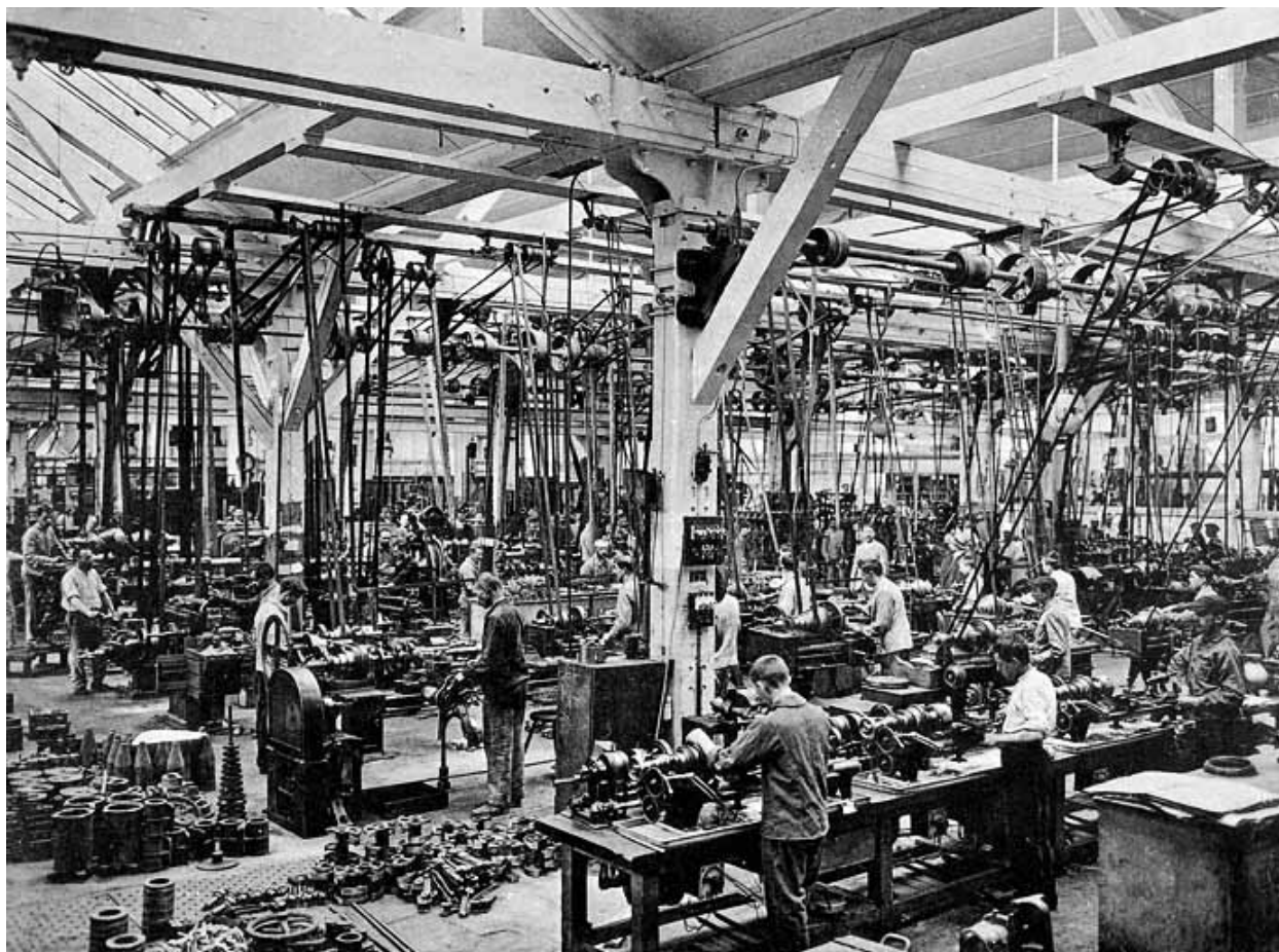
Atelier d'appareillage - Côté machines-outils.
