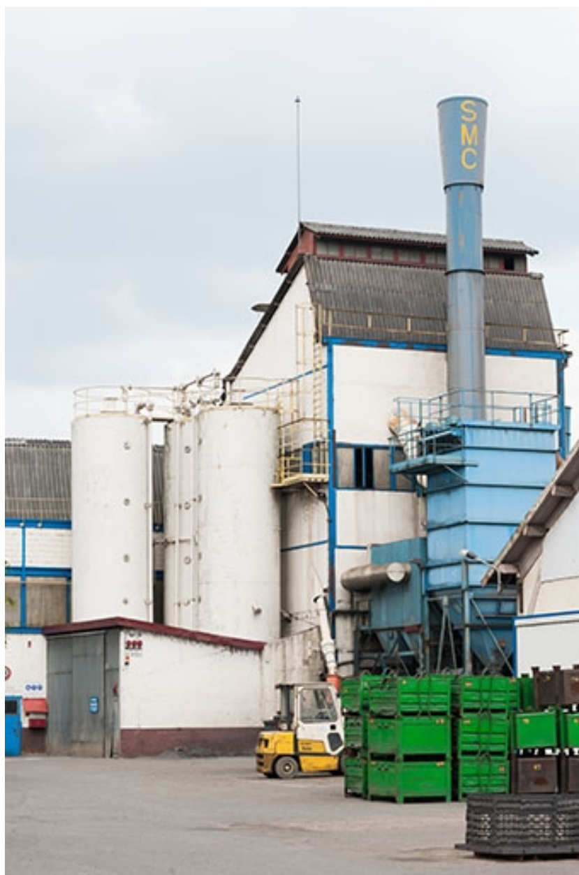
Installations de la sablerie.
