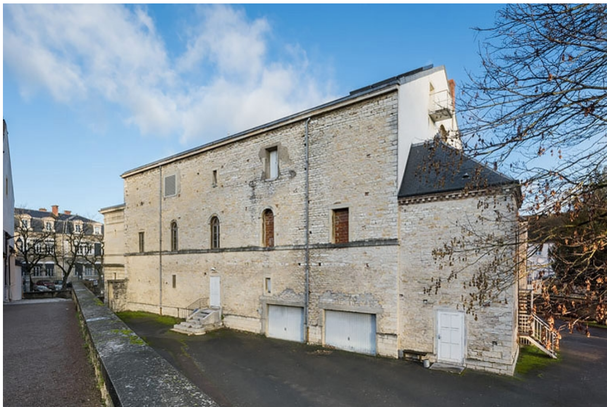
Façade latérale droite, de trois quarts droite.
