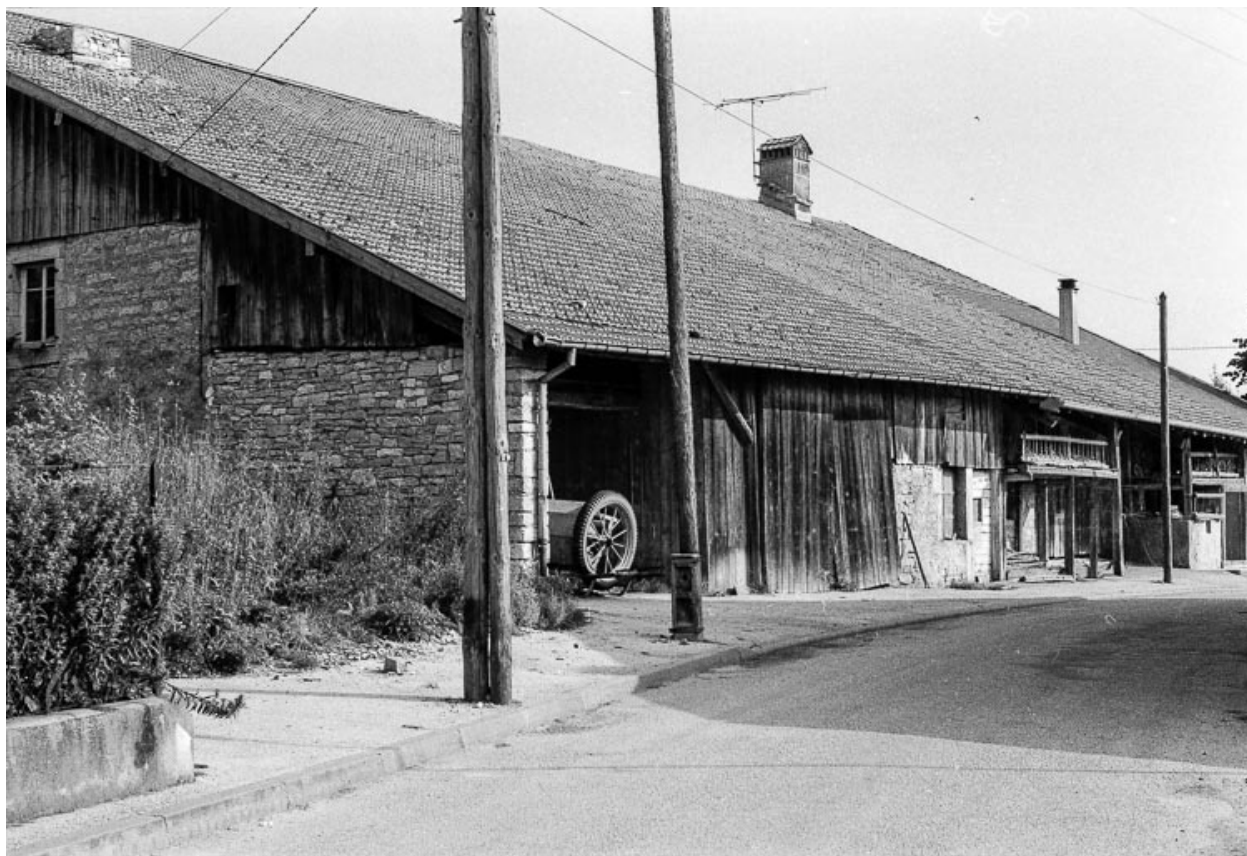
Ferme : façade sur rue.
