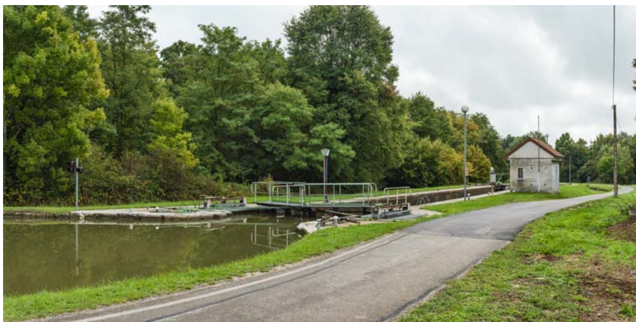
Vue d'ensemble du site d'écluse.
