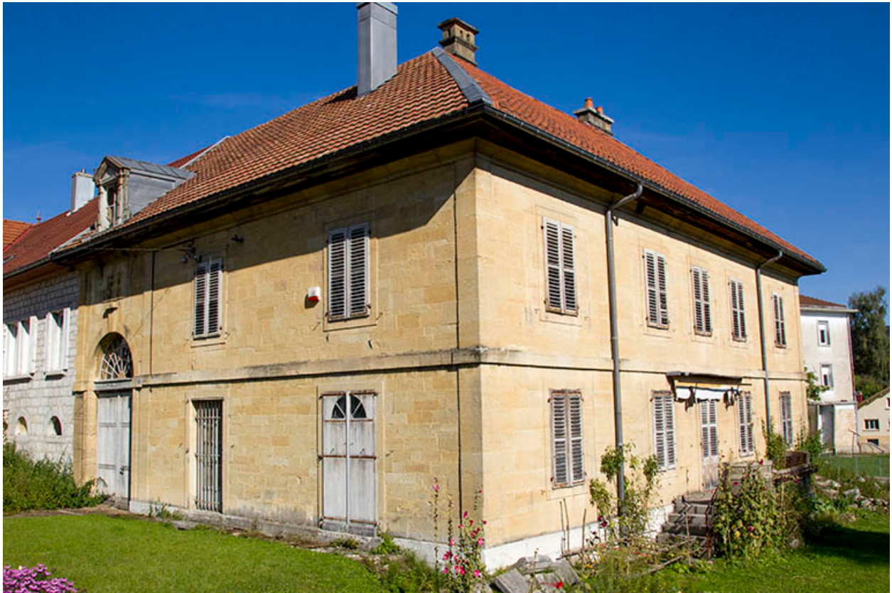
Corps sud : façades antérieure et latérale droite.
