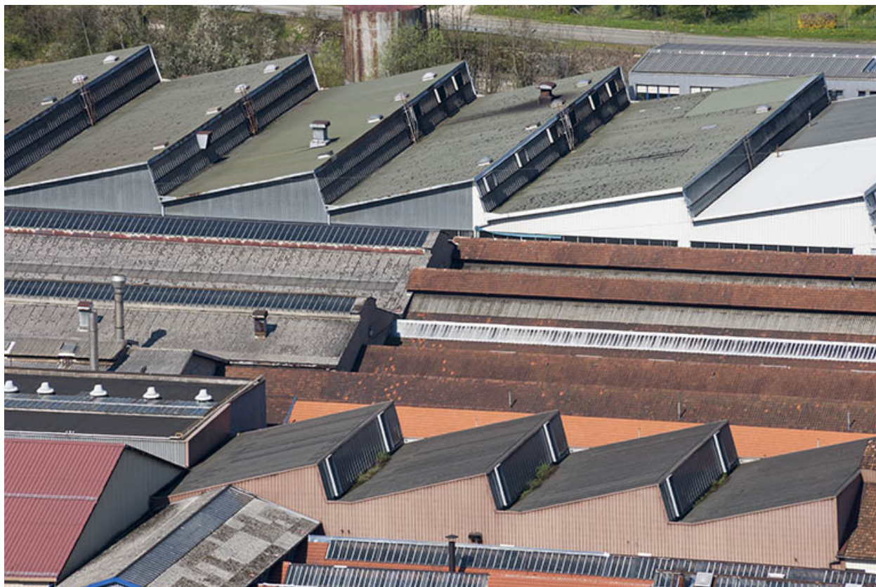
Détail de toitures des bâtiments industriels.
