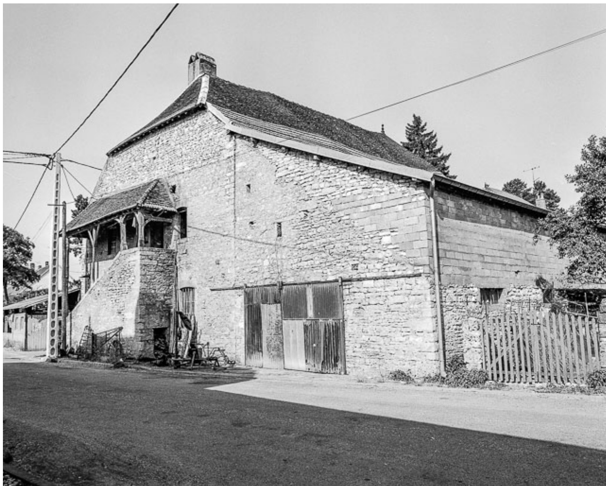
Façade avec escalier et dépendances.
