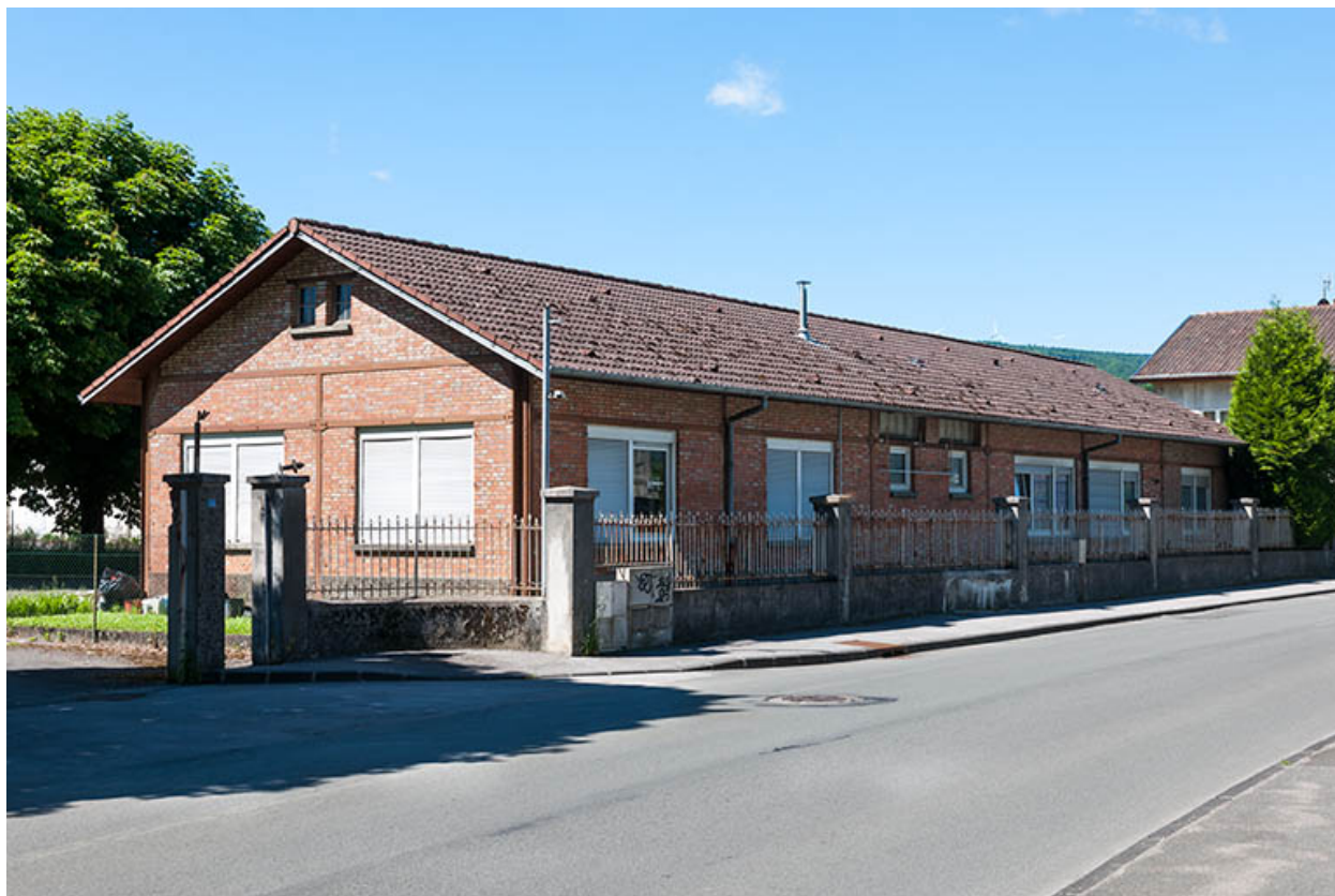
Bâtiment des logements et bureau.
