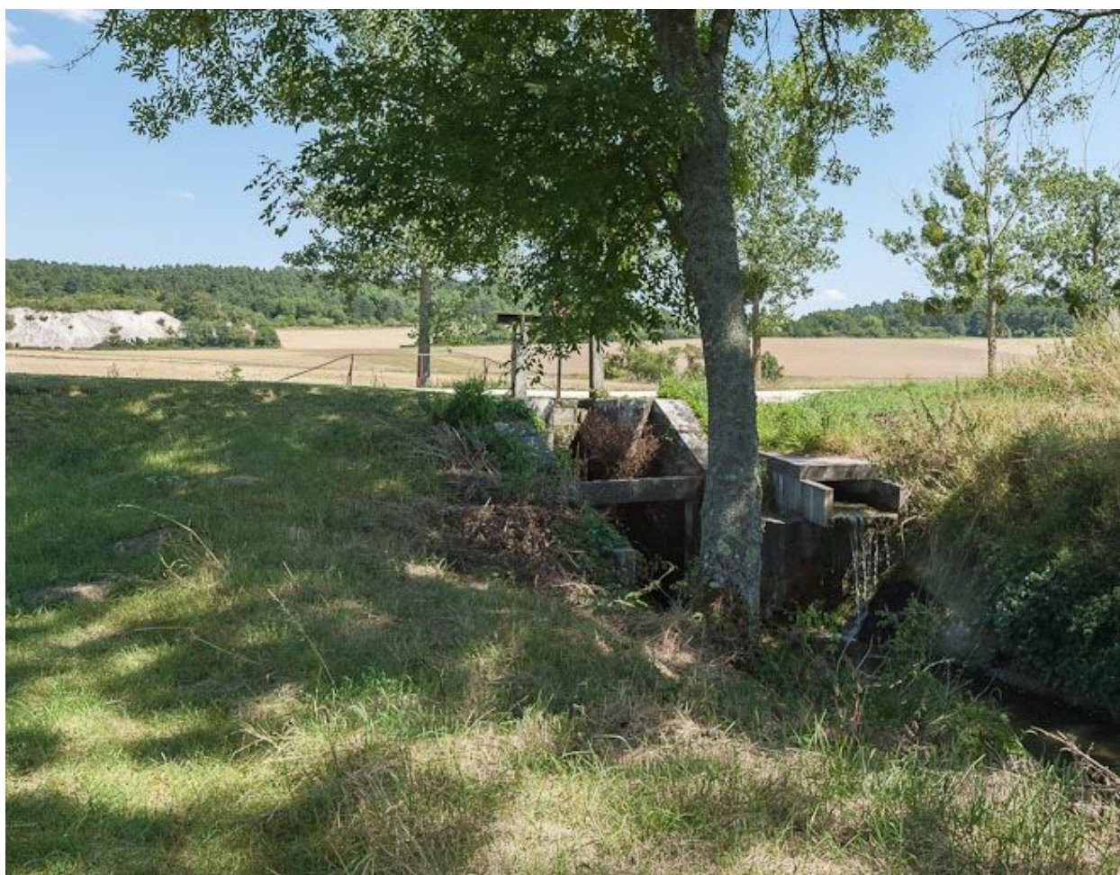
Déversoir avec vanne rive gauche.
