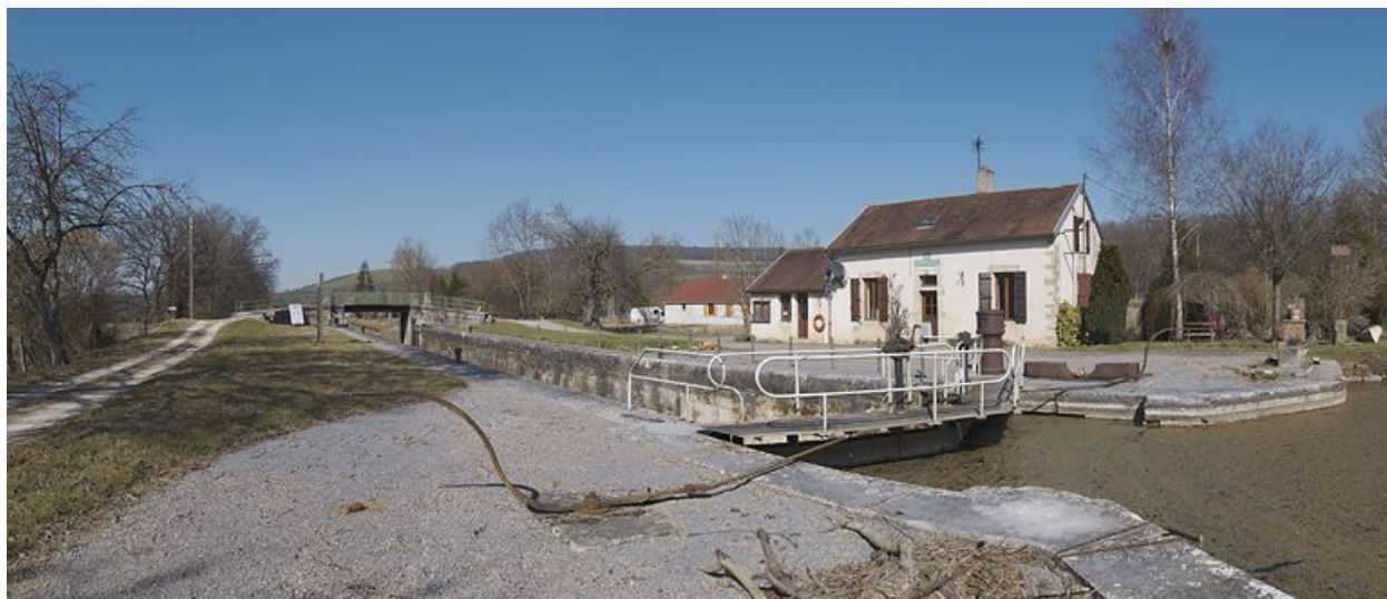
Le site d'écluse vu d'amont.
