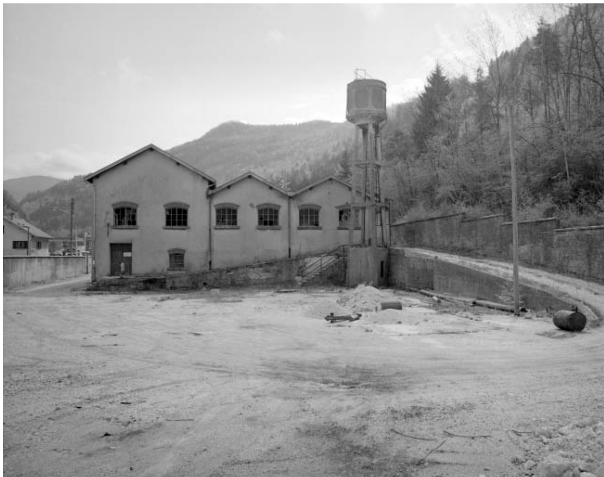
Cour, atelier de fabrication et château d'eau.
