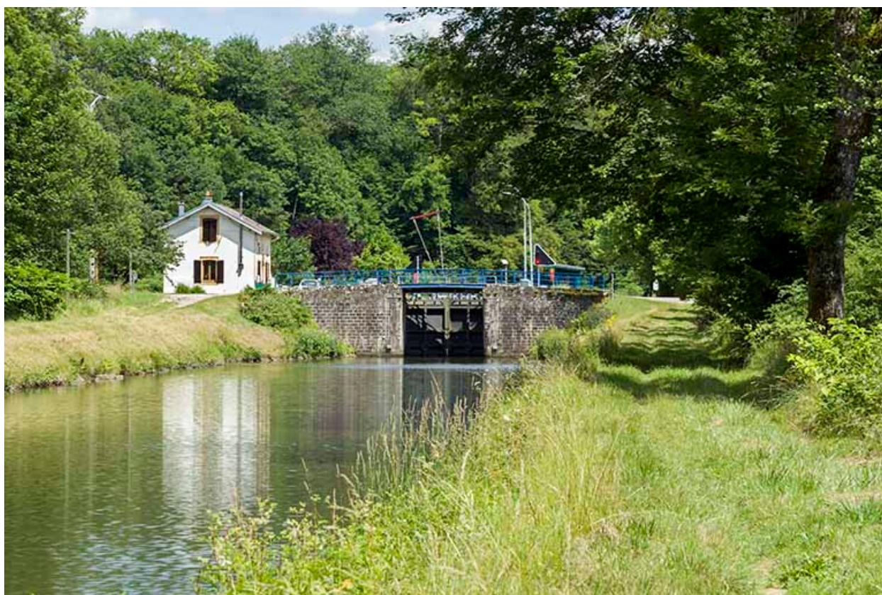
Vue d'ensemble depuis l'aval.
