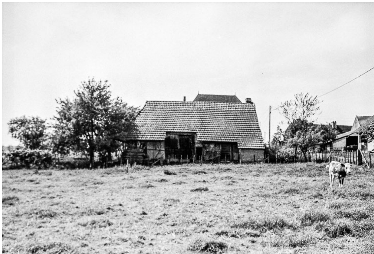
Ferme cadastrée 1963 AB : vue générale.
