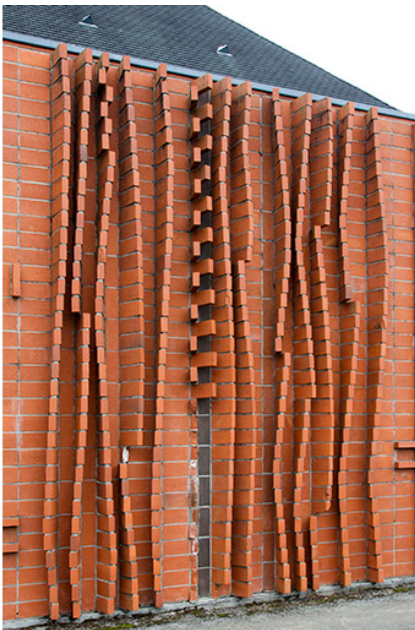
Détail du mur sud. Vue de trois-quart.
