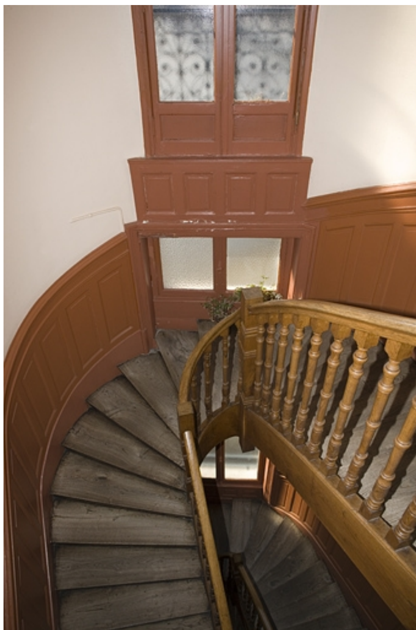
Détail d'une partie de l'escalier.
