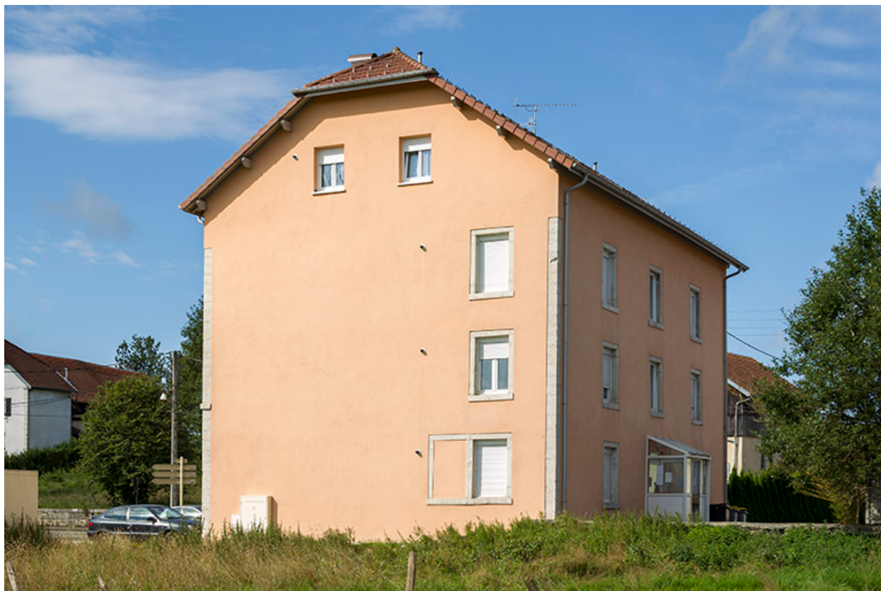
Façades antérieure et latérale gauche.
