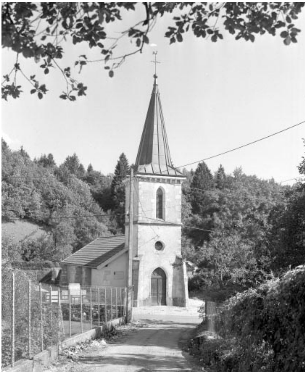
Extérieur : façade occidentale, vue de trois quarts.
