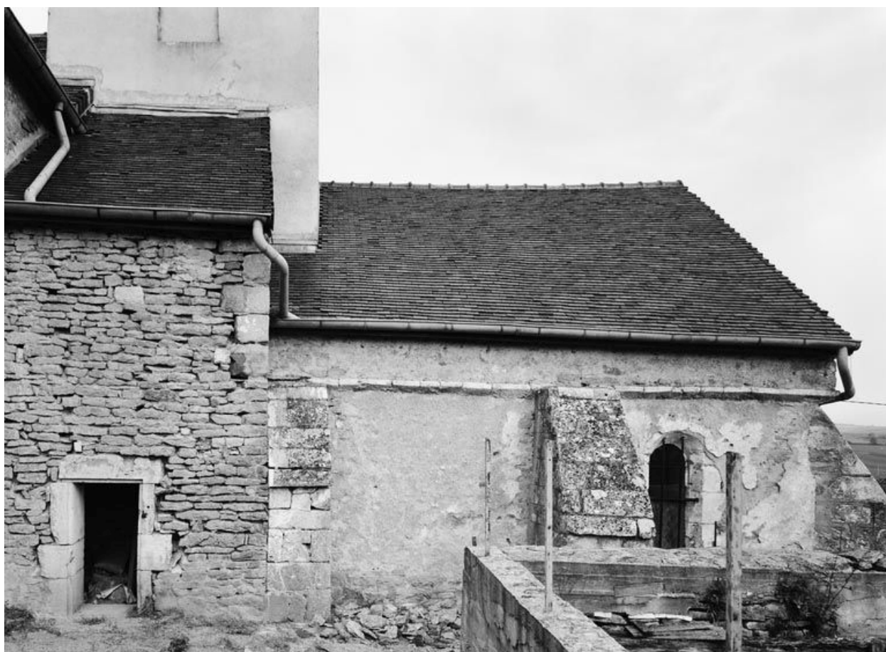
Elévation droite du choeur.
