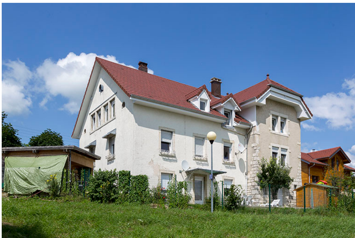
Façades postérieure et latérale droite.
