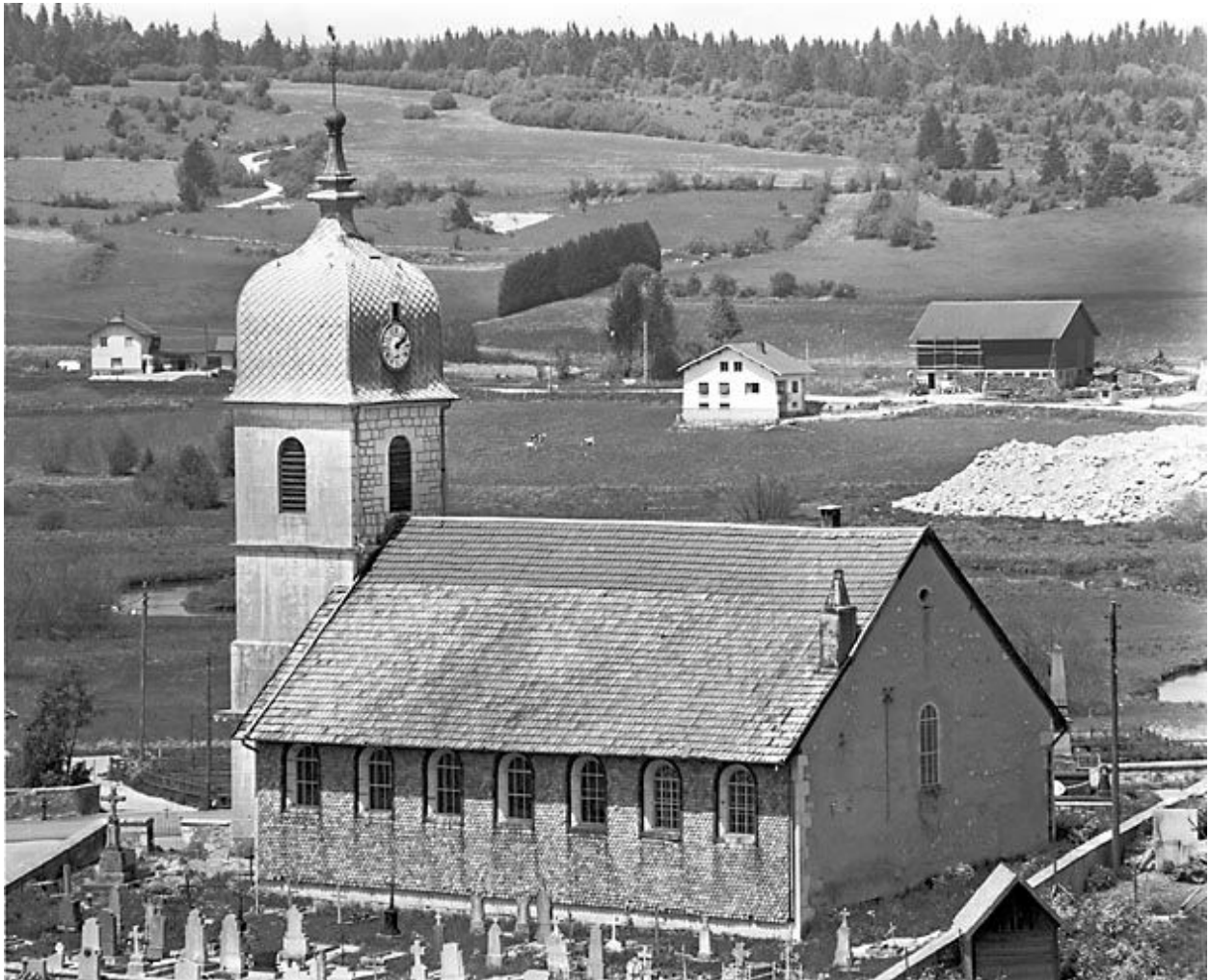
Façades postérieure et latérale droite.
