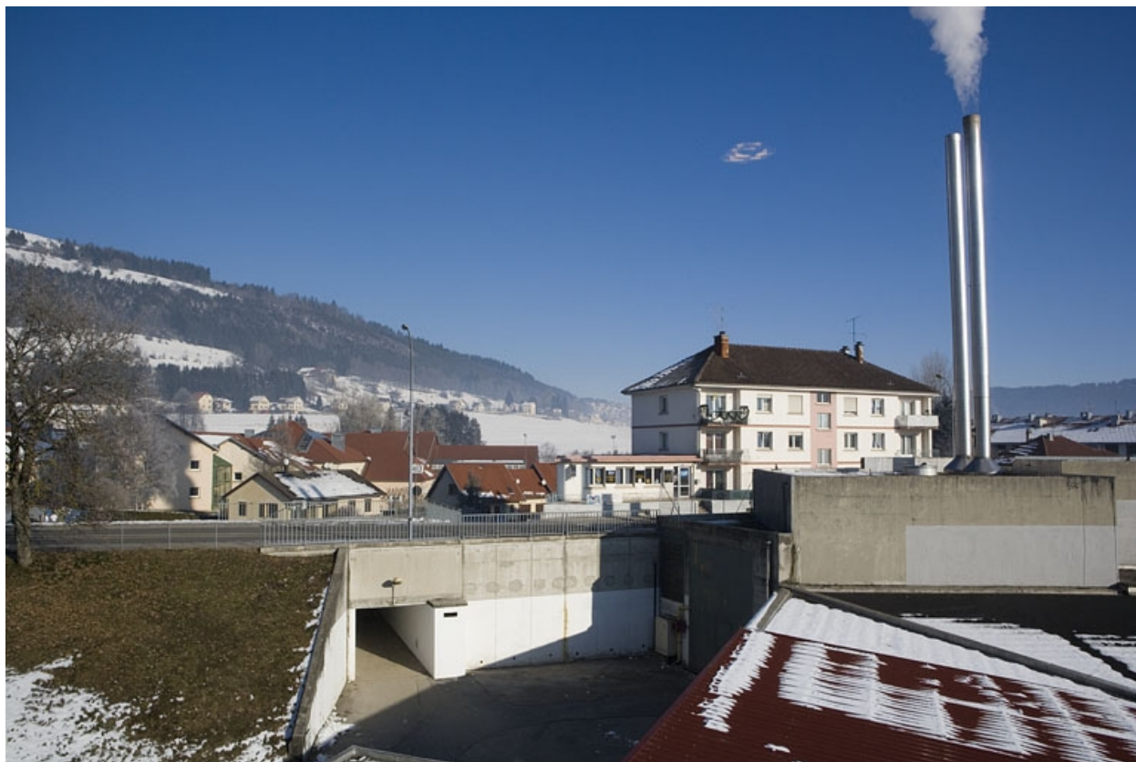
Site ancien : tunnel et chaufferie, depuis l'internat.
