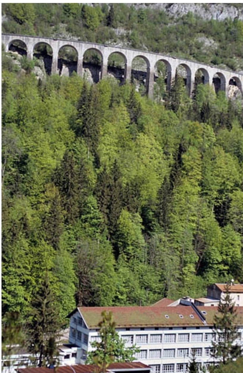
Elévation orientale, vue depuis Morez.
