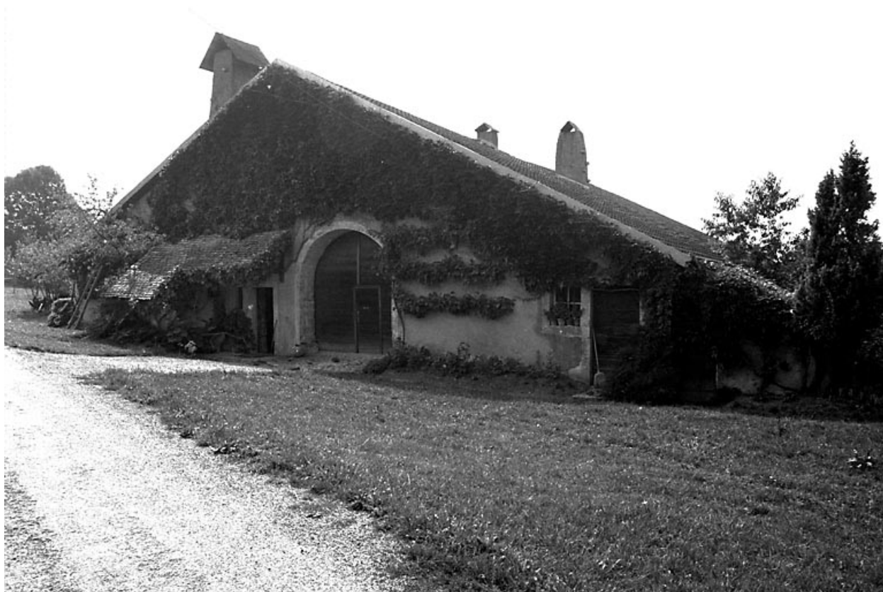
Ferme située au lieudit Bois-Vieille.
