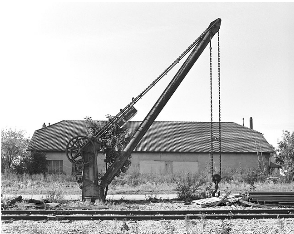
Vue d'ensemble de profil, depuis le nord-est.
