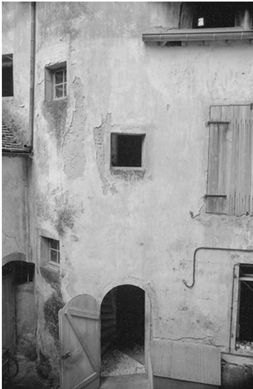
Bas de la tourelle d'escalier.
